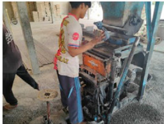
ภาพที่ 7 การเตรียมแม่แบบสำหรับอัดคอนกรีตบล็อก
