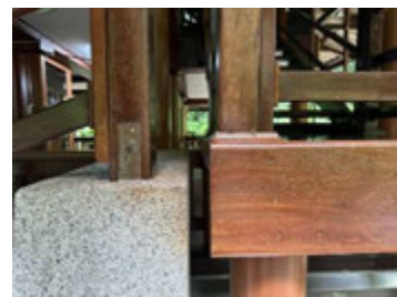
ภาพที่ 14 แสดงภูมิปัญญาในการก่อสร้างเพื่อป้องกันสัตว์และแมลงต่างๆ บริเวณตีนเสาและบันไดของกุฏิหลวงปู่่มั่น (ซ้ายและกลาง) และ (ขวา) ช่องว่างระหว่างบันไดและ พื้นชั้นสองของกุฏิหลวงตามหาบัว
