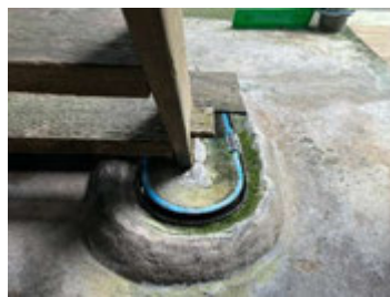
ภาพที่ 14 แสดงภูมิปัญญาในการก่อสร้างเพื่อป้องกันสัตว์และแมลงต่างๆ บริเวณตีนเสาและบันไดของกุฏิหลวงปู่่มั่น (ซ้ายและกลาง) และ (ขวา) ช่องว่างระหว่างบันไดและ พื้นชั้นสองของกุฏิหลวงตามหาบัว
