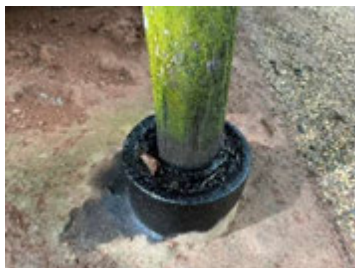
ภาพที่ 14 แสดงภูมิปัญญาในการก่อสร้างเพื่อป้องกันสัตว์และแมลงต่างๆ บริเวณตีนเสาและบันไดของกุฏิหลวงปู่่มั่น (ซ้ายและกลาง) และ (ขวา) ช่องว่างระหว่างบันไดและ พื้นชั้นสองของกุฏิหลวงตามหาบัว
