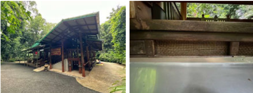
ภาพที่ 17 ภาพภูมิและช่องระบายอากาศ วัดป่าบ้านตาด
